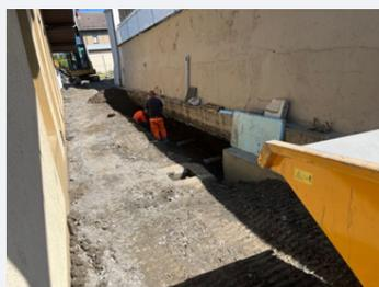
Les travaux en cours confirment la fragilité du mur séparatif entre les deux cours, dont il a fallu reprendre les soutènements.
